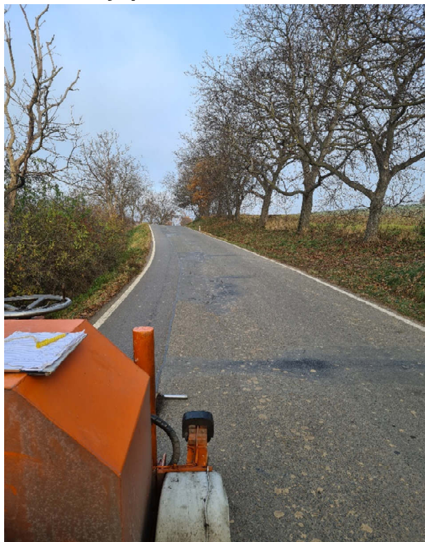
Sonda 8: km 13,711 PS, osa 1,5 m, lokální výsrava AC , GPS: 49,56272
